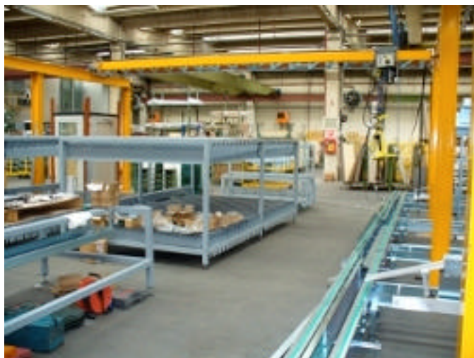
Vista frontale del carro ponte
